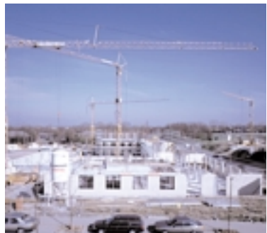
Die Quantum-Baustelle im TechnologiePark
