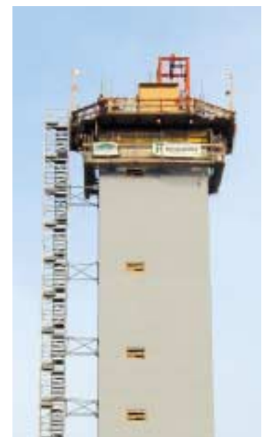
ISA Smelter: Gleitschalung
