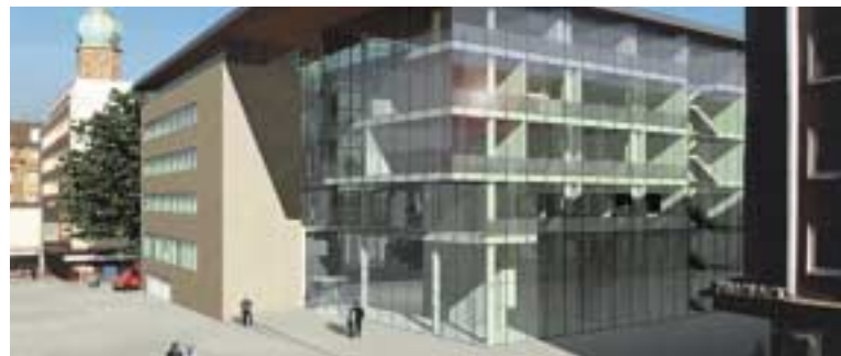
Neue Hauptstelle der Dortmunder Volksbank, Betenstraße
